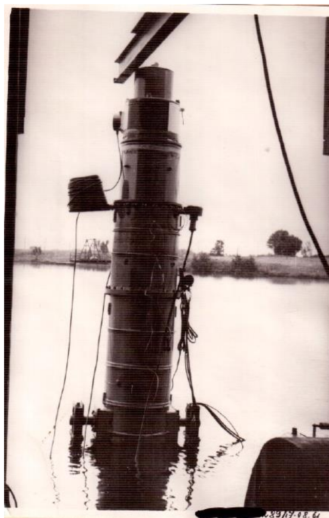
Рисунок П5.10.10 - Шахта с контейнером перед погружением
