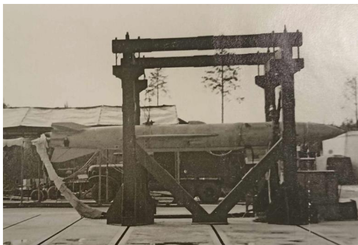
Рисунок П5.9.1 - Ракета «Аметист» на стенде перед испытаниями
